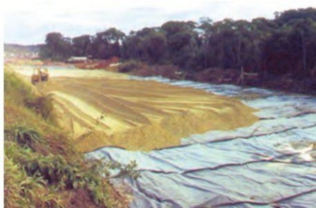
Terraplenes sobre suelos blandos
