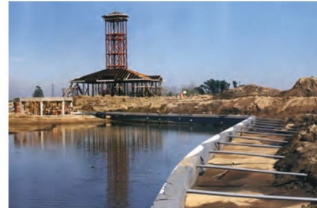
Filtro detrás de muro de contención
