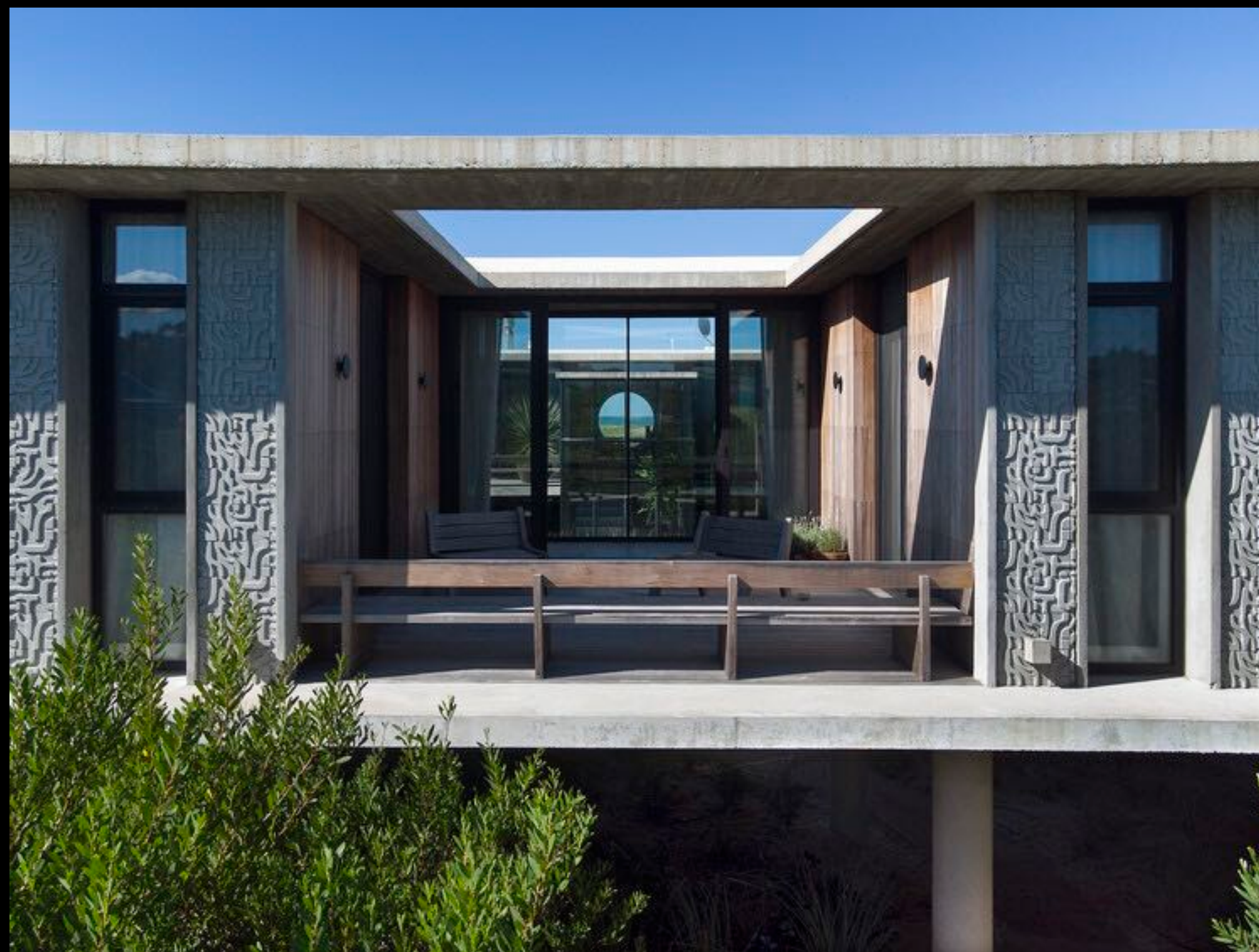
Revestimiento exterior cementicio pétreo.
